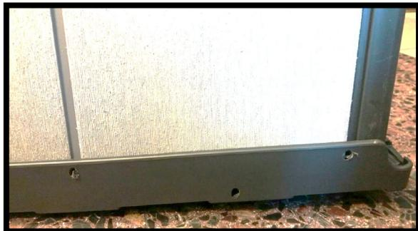
3. Bohren Sie ca. 10 Löcher von  $\varnothing$  5 mm (seitlich und hinten) in einer Höhe von 1cm Abstand vom Boden, damit das angestaute Wasser ablaufen kann
